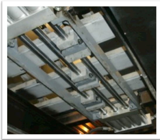
Piso vivo hidráulico
